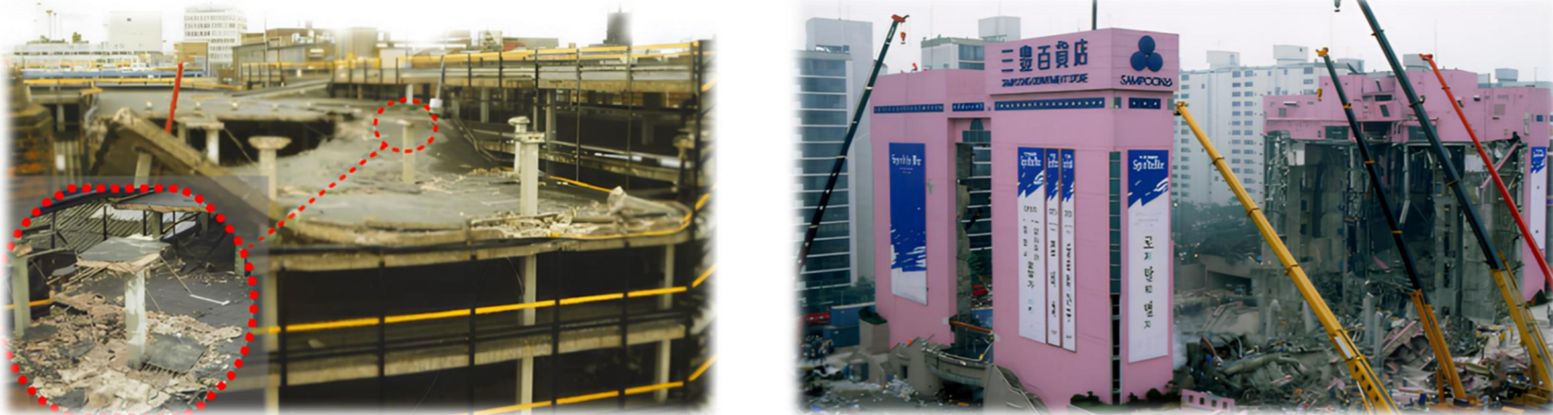
Schadensfälle infolge Durchstanzens: (links) Autoparkdeck Wolverhampton 1997 Wood 2004, (rechts) Sampoong-Gebäudes Südkorea 1995 The Korea Herald 2023
