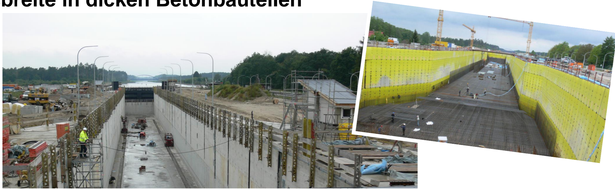
260 m fugenlose Schleuse Wusterwitz, Deutschland; Quelle: Schlicke, D.
