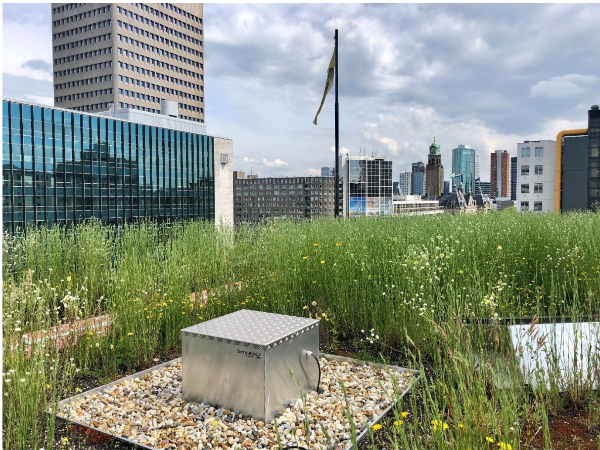
Abbildung 2: Intelligente Ablaufdrossel Smart Flow Control auf einem Retentionsgründach in Rotterdam.
