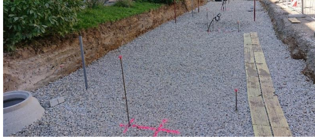
Belüftungs- und Verteilschicht
