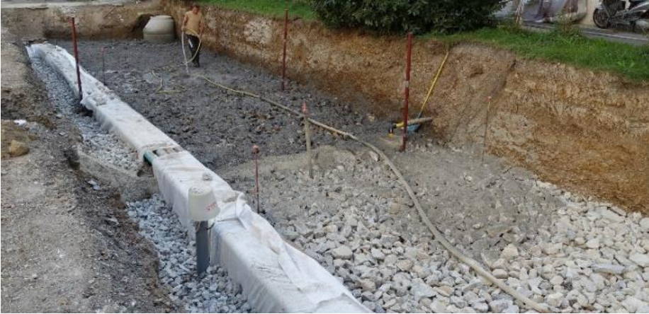
Eingeschlämmtes Schwammstadtsubstrat
