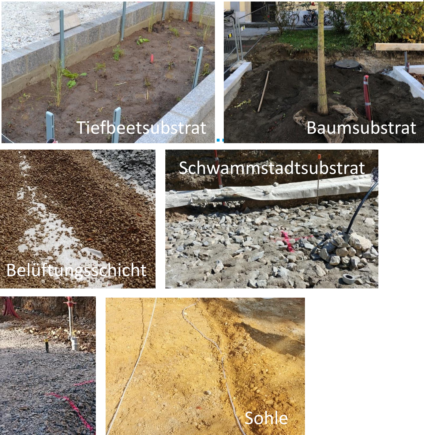
Abb. 3: Verbaute Substrate bzw. Schichten im Schwammstadtsystem am Leonhardgürtel.
