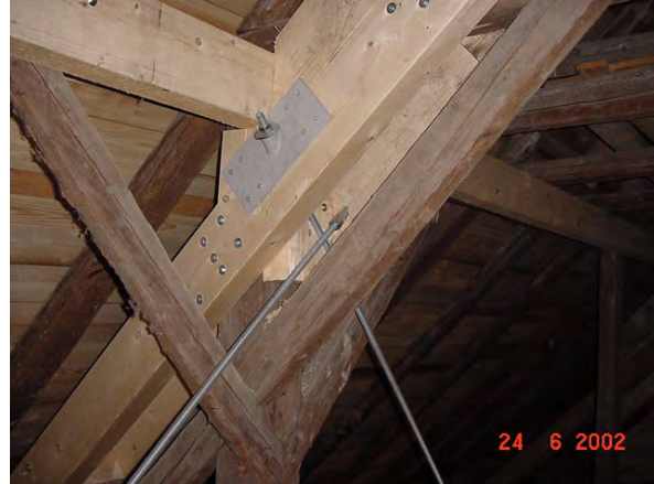
Abb. 4.9: Abhängung der Zangenebene, geometrische Anpassung an Bestand notwendig
