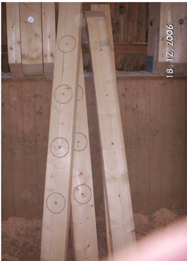
Abb. 2.7: Ausführungskontrolle einer Verbindung mit Einlassdübel Typ A vor dem Zusammenbau
