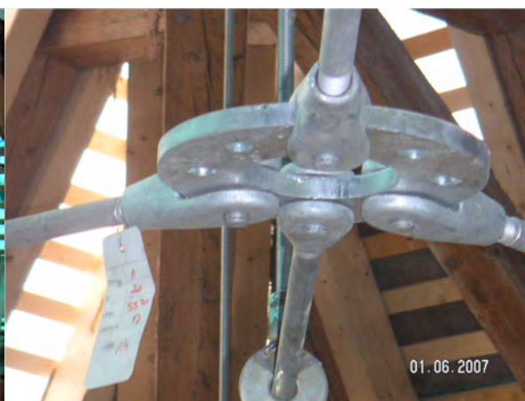
Abb. 3.9: Detail Ringscheibe
