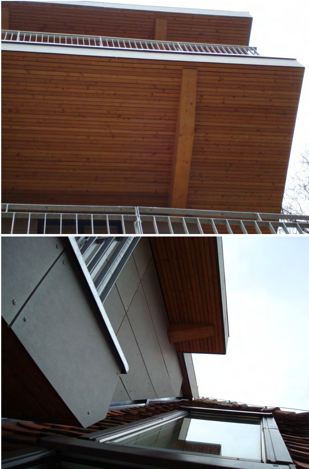
Abb. 4.16: Balkonuntersichten und Anschluss des Neubaukubusses ans Satteldach
