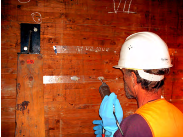
Abb. 3.3: Verpressen der abgeklebten Risse (Foto: Finnforest Merk)
