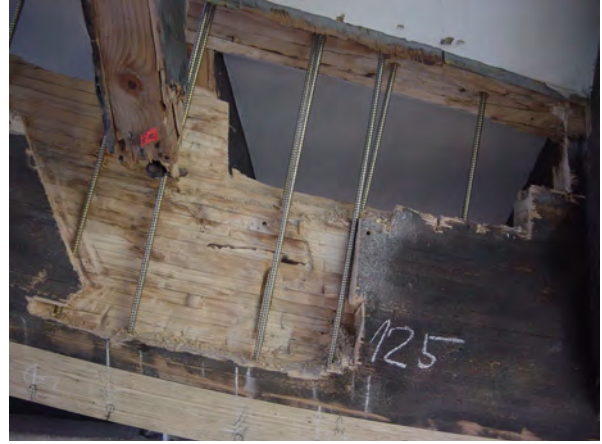
Abb. 10.2: Rippe mit neuer Untergurt und Quer- zugverstärkung (Hörsaal 1, Rippe 15) (Foto: Finnforest Merk)
