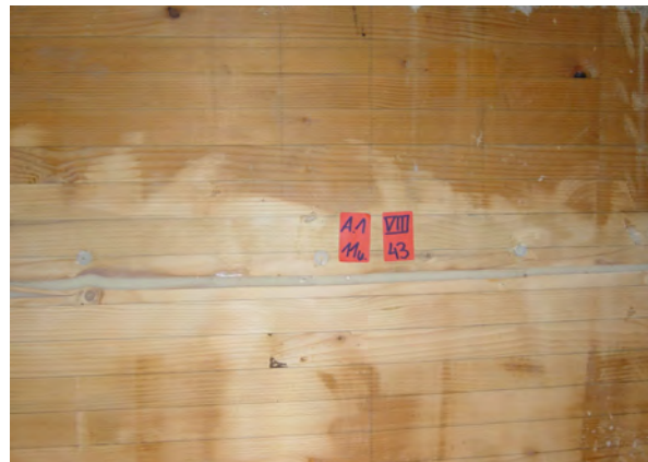
Abb. 3.6: abgelenkter Querträger mit breitem verpresste Riss (Foto: Finnforest Merk)
