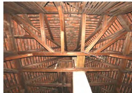
(a) Kehlbalkenlage im Walmbereich
