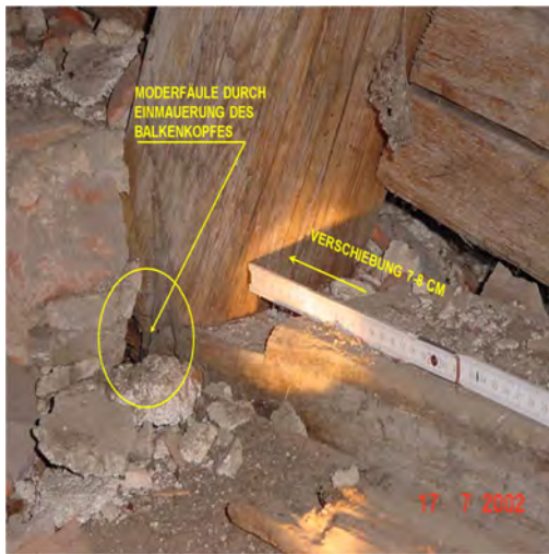
Abb. 3.2: Fußpunkt mit Verschiebung und historischer Verstärkung
