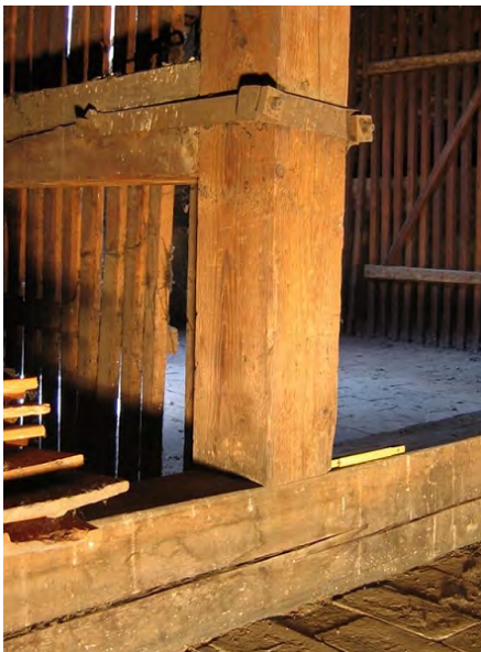
(a) Stuhlsäule samt Mauerbankriegel und Bundtram
