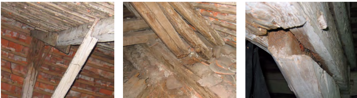
Abb. 5.2: links: „sanierter“ Firstpunkt [8]; mitte: fehlender Bundtram [8]; rechts: Kopfband Detail [8]
