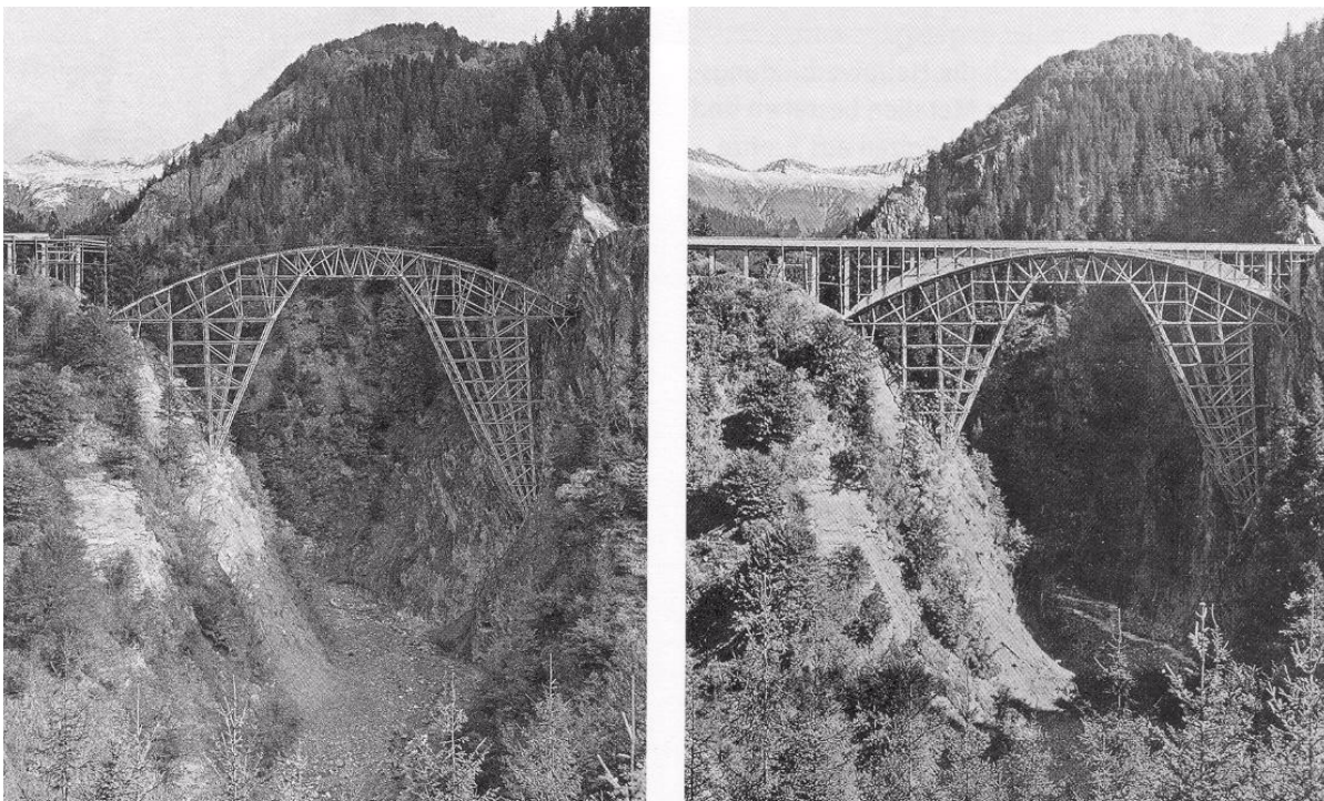
Abb. 5.2: Lehrgerüst Salginatobelbrücke, in „Zuschnitt 19“
