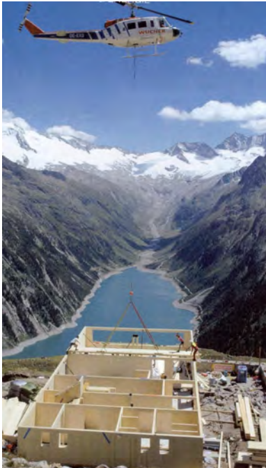
Abb. 8.2: Montage der Olpererhütte aus [10]
