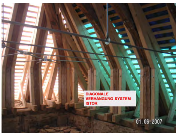
Abb. 3.8: Verhängung mit ISTOR-Stangen
