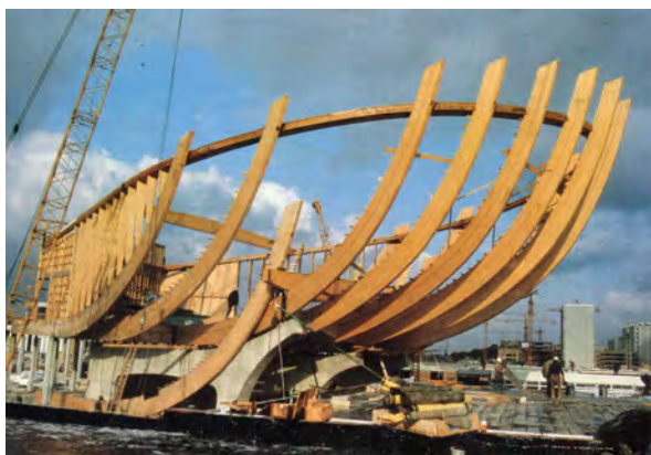
Abb. 2.3: Montage der Haupttragelemente des Hörsaales 1 aus [2]
