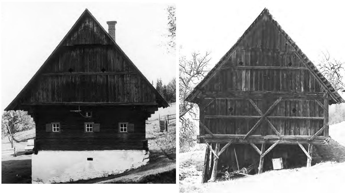
Abb. 3.1: Blockbau und Ständerbau a) Blockbau vulgo Steinbauer in Unterwald – Wohnhaus b) Ständerbau vulgo Pilz Irgl in Unterwald – Stallgebäude
