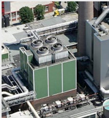
Abb. 2: Kühltürme auf dem Gebäude der Absorptionskälteanlage
