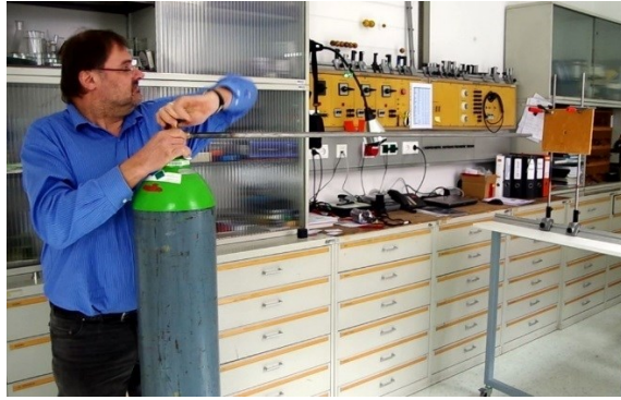
Abbildung 44: Kurzes Öffnen des Ventils der Druckluftflasche (Bild: W. Winkler)
