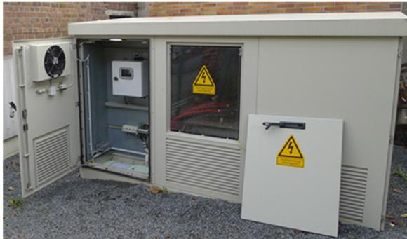
**Abbildung 1: Frontansicht der Kompaktstation NDV 1600 mit eingebautem ERT**
